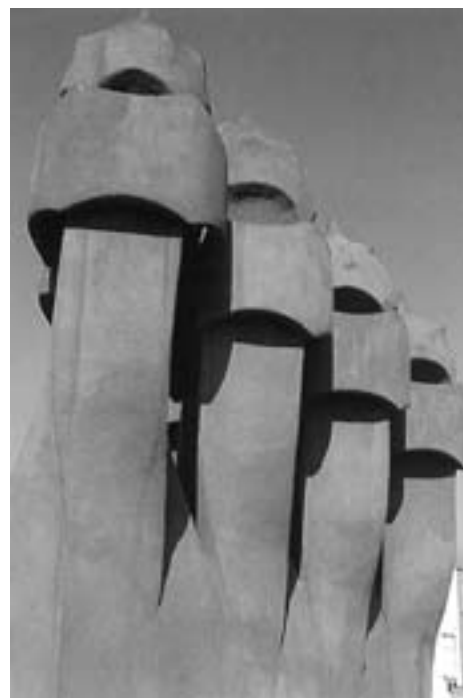
A. Gaudí, casa Milà (o La Pedrera – Barcellona – 1906-1910), particolare del tetto.
